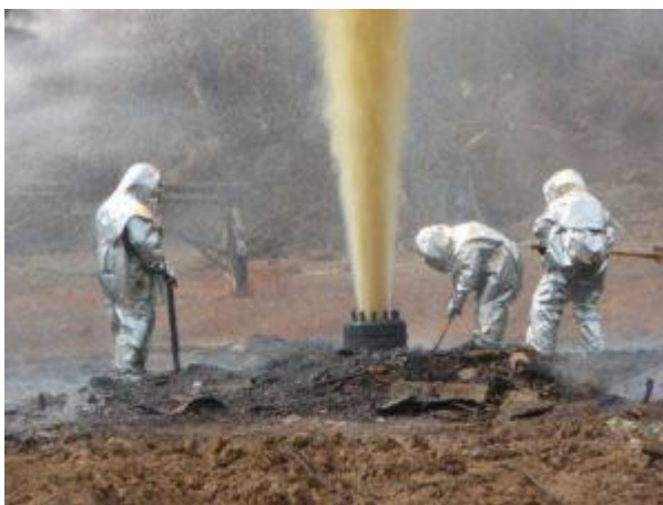
Рис. 1. Работа аварийно-спасательной службы по ликвидации открытого фонтана нефти
